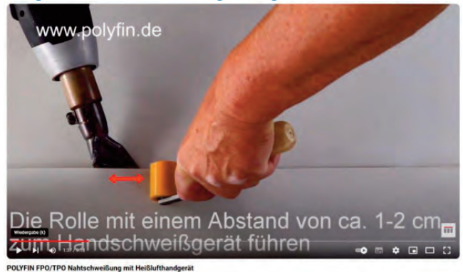
Polyfin lemez hegesztése - video Hegesztés kézi meleglevegős berendezéssel
